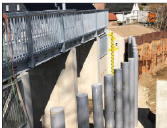
Ansicht Damm Vorderseite
