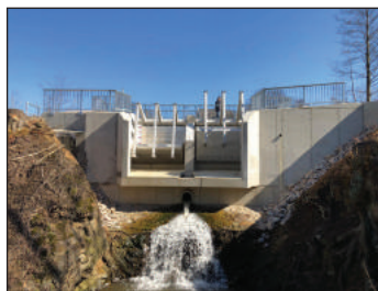
Ansicht Damm Rückseite
