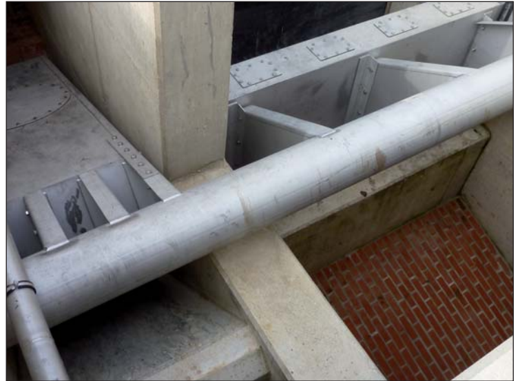
Bild 1: Wehranlage mit Anordnung Schwimmkörper links
